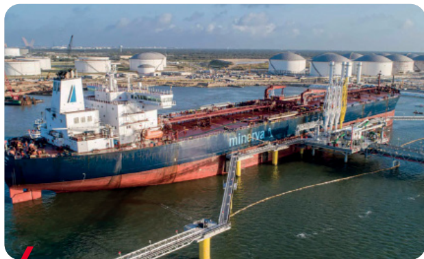
Buckeye LNG terminal, Texas, USA
